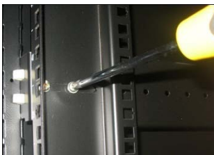
用于固定 U 柱的螺栓
